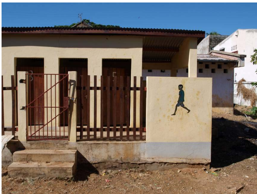
Bloc sanitaire construit par Ecoles du Monde dans une école de Mahajanga
