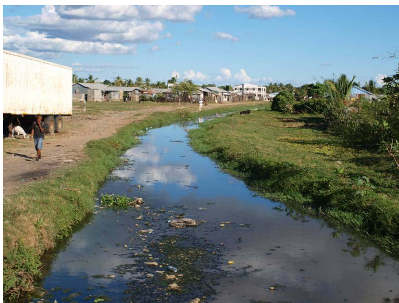
Canal principal d'assainissement du vallon Metzinger
