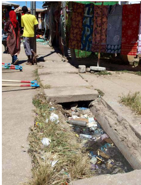
Canal de collecte des eaux usées obstrué par des déchets solides à Mahajanga
