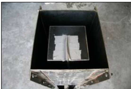
Scotcher le tuyau en plastique depuis le milieu intérieur du moule pour l'empêcher de bouger et de se remplir de béton
