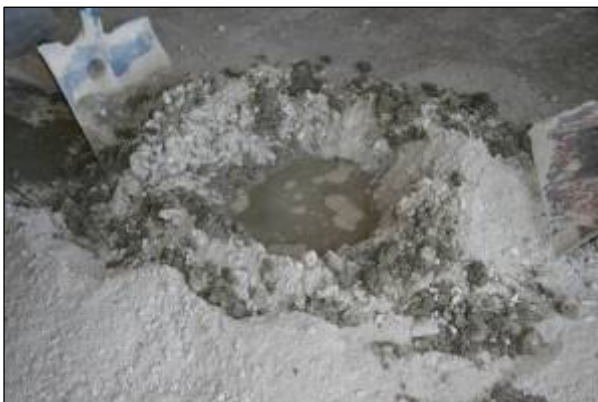
Mélanger les ingrédients secs ensemble à l'aide d'une pelle. Faire un trou peu profond dans le centre et versez de l'eau. Bien mélanger et continuer à ajouter de l'eau jusqu'à ce qu'il atteigne la consistance voulue.
