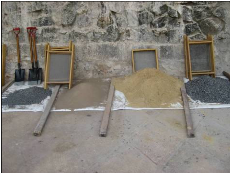
Des piles de sables organisées et séparées empêcheront le sable et gravier de se mélanger
