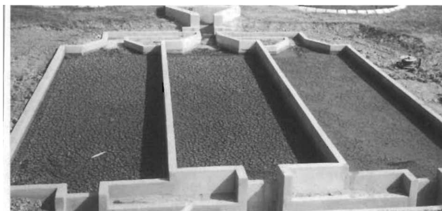
Fig. 55: Lits de séchage des boues construits par l'Université de Chiang Mei et GTZ en Thaïlande [photo: Sasse]
