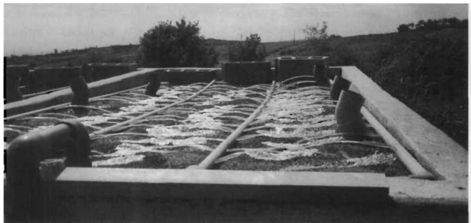
Fig. 38: Filtre vertical en cours de chargement. Construction hors sol réalisée par Nature & Technique, D Esser, pour une fromagerie dans le Sud de la France [photo: Sasse].
