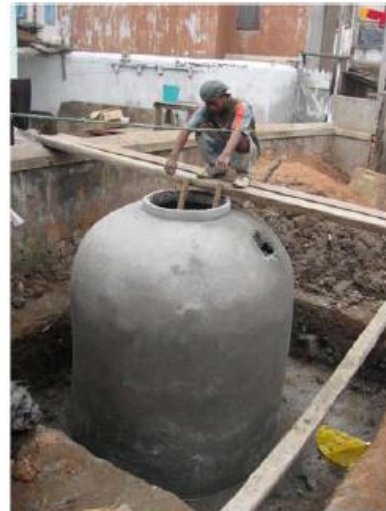
Figure 3 : deux exemples malgaches, la micro-fosse septique en buses et la fosse septique en ferrociment.
