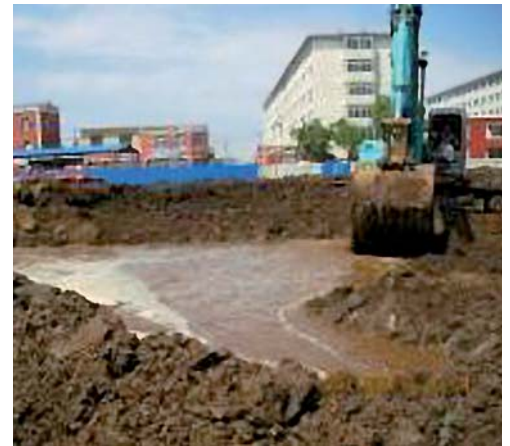
Pérdidas debido a construcción caótica
