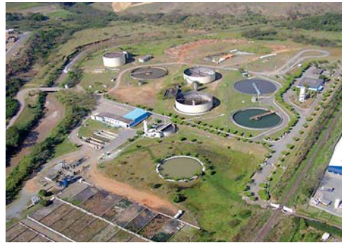
Planta de tratamiento de aguas residuales
