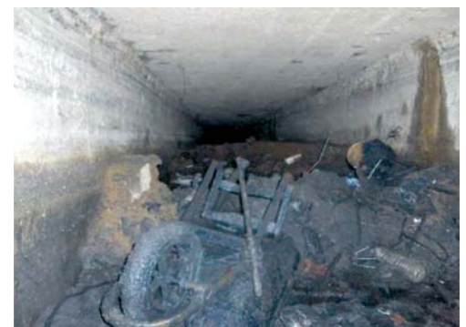
Desechos en un colector de aguas residuales, antes de la limpieza
