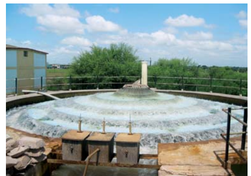
Aeración del agua cruda en una planta potabilizadora
