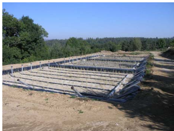
Alimentation par drains, posés au sol
