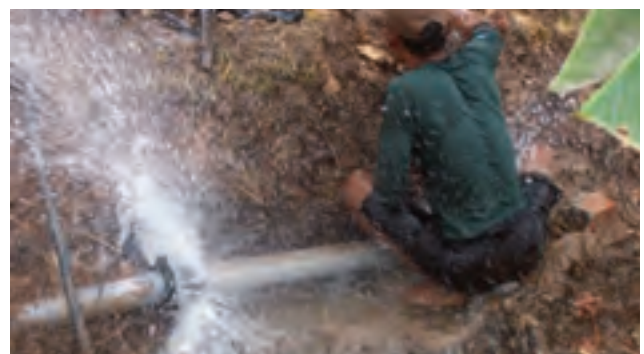
Repairing a distribution leak (d)
