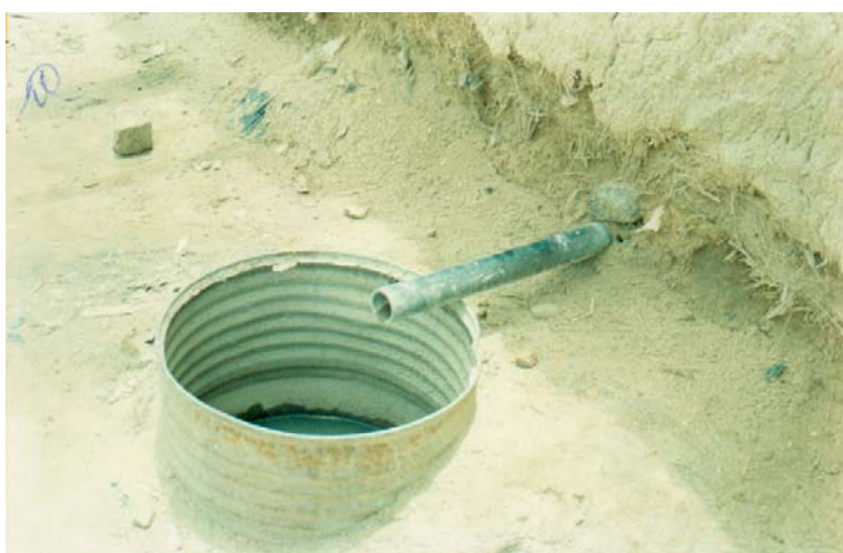
Photo 5 : Structure de collecte des eaux usées et d'excrétas qui sera vidangé dès le lendemain par les usagers.
