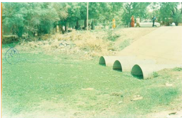
Photo 1 : Les rejets de toutes les sociétés industrielles de la ville de N'djaména sont déversés dans les drains naturels de la ville qui convergent tous vers le fleuve Chari. Au passage dans les bas fonds, elles sont prélevées pour la culture des produits de contre saison vendus sur tous les marchés de la ville.
