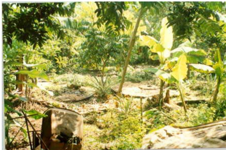
Photo 6 : état de délabrement de l'un des décanteurs digesteurs de Biyemassi
