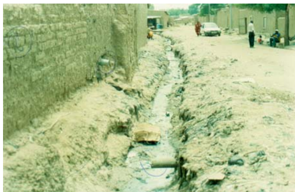
Photo 2 : Types de drainage des eaux usées les plus répandus à N'djaména. Les tuyaux observés proviennent d'une industrie de peinture qui rejette ses effluents liquides directement dans un drain à ciel ouvert.
