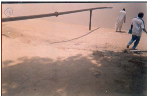
Photo 3 : Un des tuyaux par lequel tous les déchets liquides de l'Abattoir de N'djaména sont évacués directement dans le fleuve Chari sans traitement, même sommaire.
