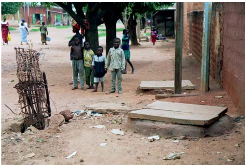
Cliché 9. Secteur 12 (Niénéta). Les puisards, mal couverts, constituent de véritables gîtes larvaires. On les place de préférence en-dehors de la cour, dans l'espace limitrophe (cliché Bouju, 2001)
